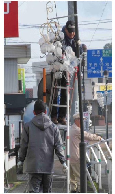
イルミ撤去作業
